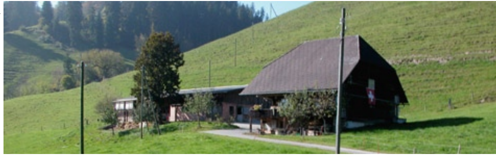
In vielen «Heimettlis» wird der Ofen in der Stube auch heute noch über den Kochherd eingeheizt. Früher waren offene und komplett verrauchte Küchen üblich. Im bis unters Dach offenen Rauchfang wurden Fleisch- und Wurstwaren geräuchert. Bei schlechtem Wetter drückte es den Rauch durch den Abzug im Dach zurück.
